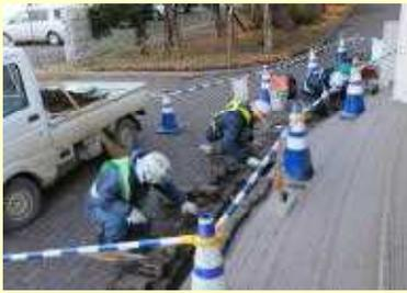
11月27日(水)協和八光建設様のご厚意により、児童玄関前のブロックの補修、校舎と地面の間の隙間の充填、さらに舗装部分の欠損箇所を補填を行っていただきました。心より感謝いたします。
